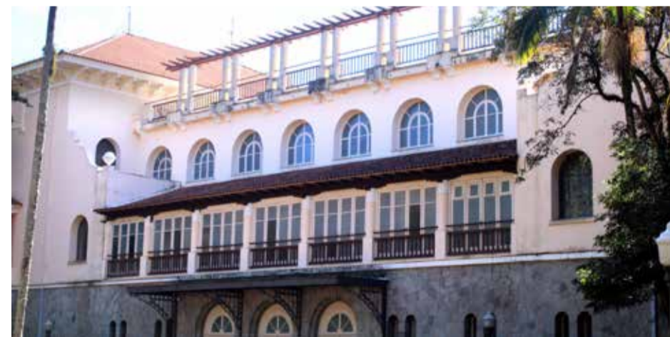
Palace Cassino localizado no Parque José Afonso Junqueira, está entre as grandes construções da década de 1930 na cidade
